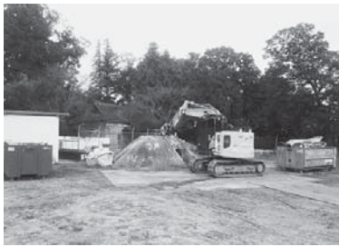
▲ 解体が始まった旧小川小学校プール
