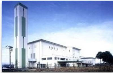
霞台厚生施設組合環境センター
