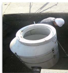
マンホール設置工事の様子
