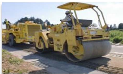
道路補修工事
