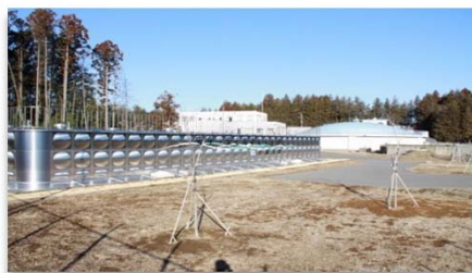
水道局の貯水タンク
