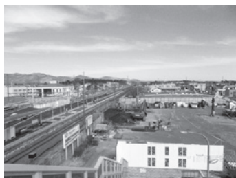
▲工事が進む羽鳥駅
