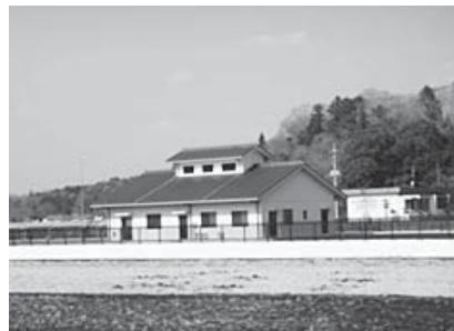
農業集落排水施設
