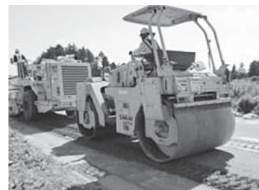
道路維持補修の様子
