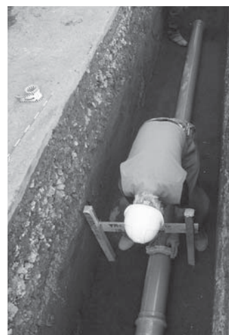
下水道管布設状況
