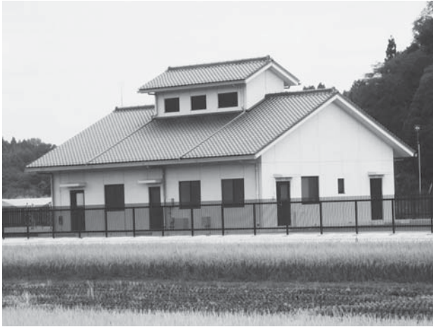
巴中部地区農業集落排水処理施設
