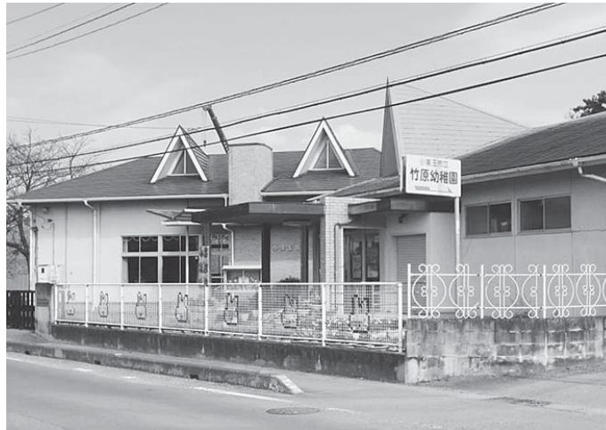
耐震工事が行われる美野里地区の幼稚園（竹原幼稚園）
