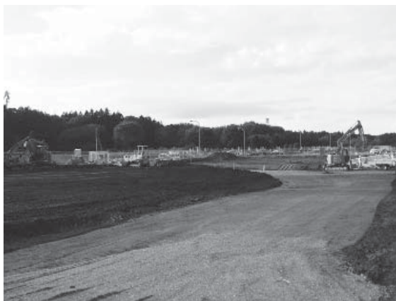
拡張工事が始まった美野里霊園
