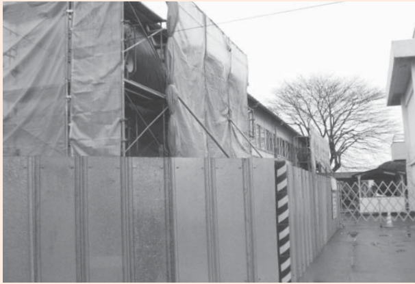
竹原小学校体育館耐震補強工事
