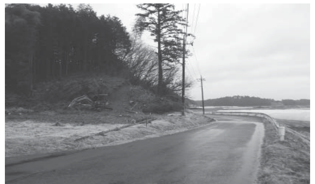
栗又四ヶ線工事着工（上馬場地内）
