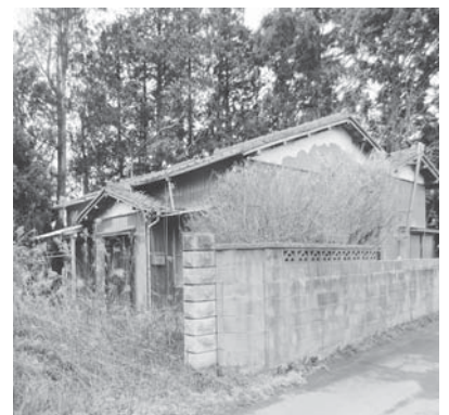
放置されている空き家
