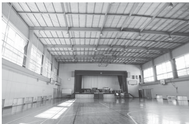
緊急経済対策費で今年度に耐震補強工事が行われる(野田小学校体育館)
