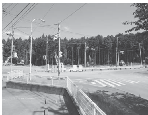
工事が始められた都計道村上六軒線（石岡市）
