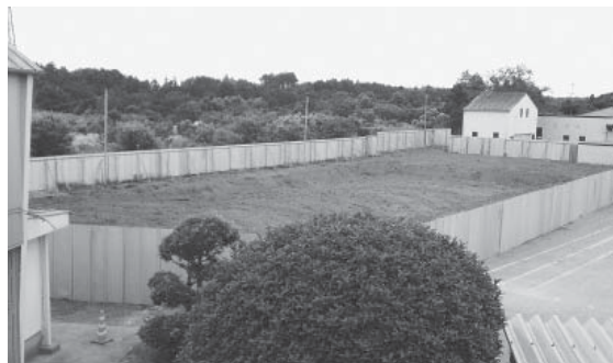
仮校舎建設地となるプール跡地が更地に (竹原小学校)
