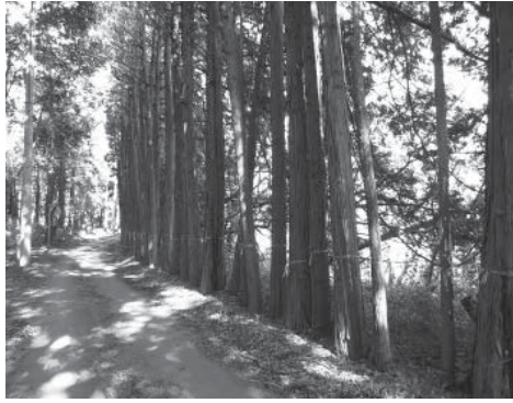
樹木伐採がはじまる(仮称)宮田防災公園へ通じる10484号線
