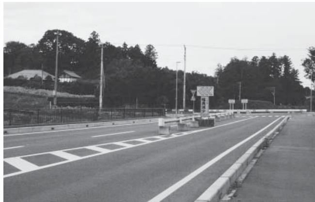
30年度の完成を目標に整備が進む広域幹線道路(張星地内)
