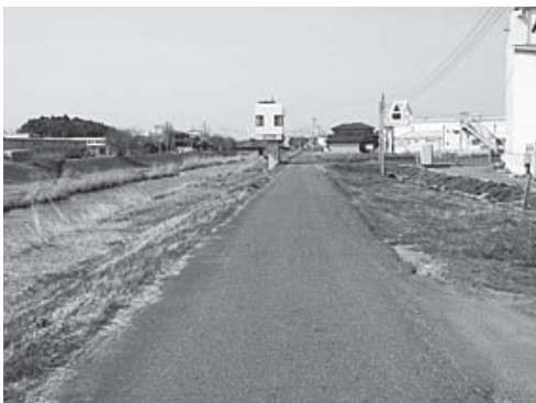
今回認定された園部川堤防の道路（川岸地内）
