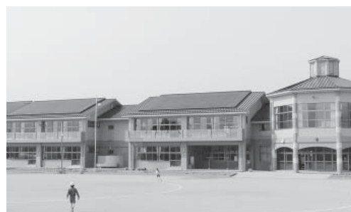
50Kwの太陽光発電システムが設置されている下吉影小学校校舎。屋根の太陽光パネルで発電した電力量が、玄関ロビーに表示されている
