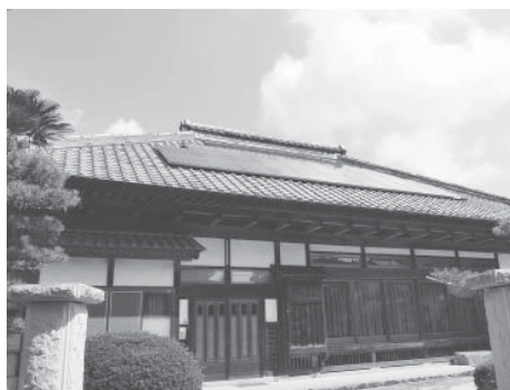
市の太陽光発電システム補助金を活用し、パネルを設置。電気料金だけでなく、初期費用も抑えることができる
