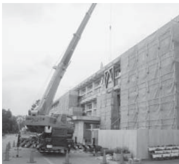
23年度は、9月末までに小川南中学校校舎、羽鳥小学校新校舎の耐震工事が完了した (写真：小川南中学校)
