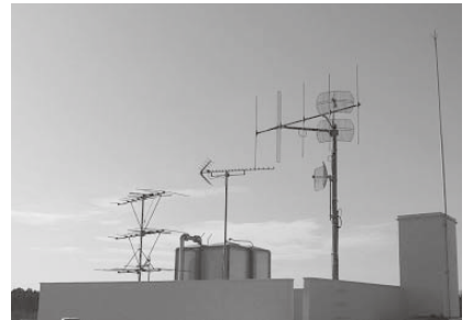
災害時等を含め市民への適切な情報提供を行う防災行政無線（屋上アンテナ）。現在も旧3町村時代からのシステムをそれぞれ運用。一本化にはデジタル化も含めた移行費用が大きな財政負担
