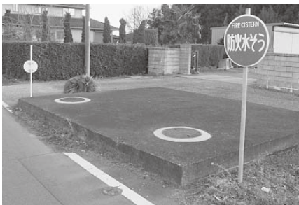
消火活動に欠かせない水の供給源として、市内各所に設置されている防火水槽や消火栓などの消火施設。設置・管理コストと活用時の妥当性に配慮した対応を求めたい
