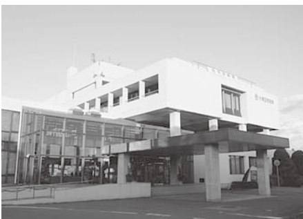
本庁舎・小川総合支所は建設当時から30年以上を経過。合併時に策定した新市建設計画でも建設に向けた検討をすることが明記されている
