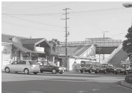
早期橋上化が待望されるJR常磐線の羽鳥駅。平成19年3月、橋上駅化した友部駅では周辺地域の一体的な再整備を図り、その財源にまちづくり交付金を活用している
