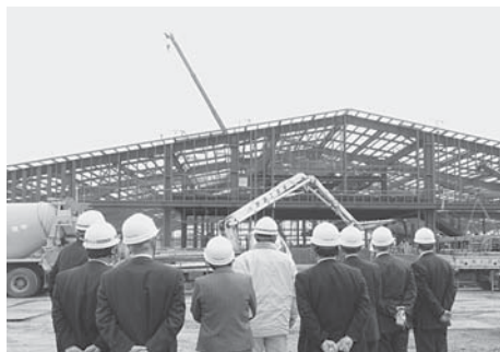
9月からの稼働に向けて整備が進められる給食センターの建設現場。(3/16現在)当面、玉里地区を除く市内幼小中学校の児童生徒分の約4700食を配食する予定
