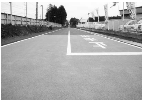
石岡市・県とともに、8月中の実証運行開始を目指す。現在、車の誤進入防止の遮断機、待合所等の設置工事を進めている(かしてつ跡地バス専用道・石岡市境界付近)
