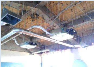
エアコン設置
