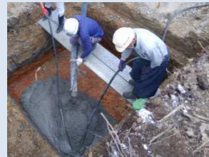
増築予定場所のコンクリート打設
